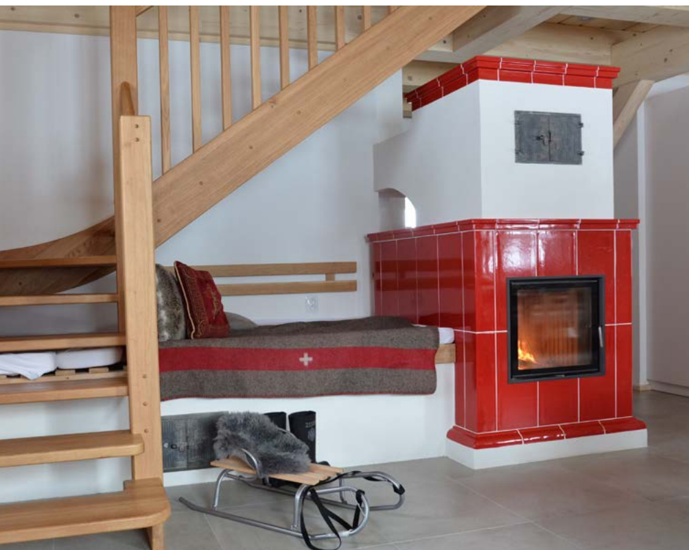
Šamotové ohniště Brunner GOF s tahovým systémem MSS, který pomalu vytápí ohřívárnu, aby obyvatelům bylo teplo, i když oheň v kamnech již dávno vyhasl. Kachle v rudé glazuře Kamnářství Bechyně
