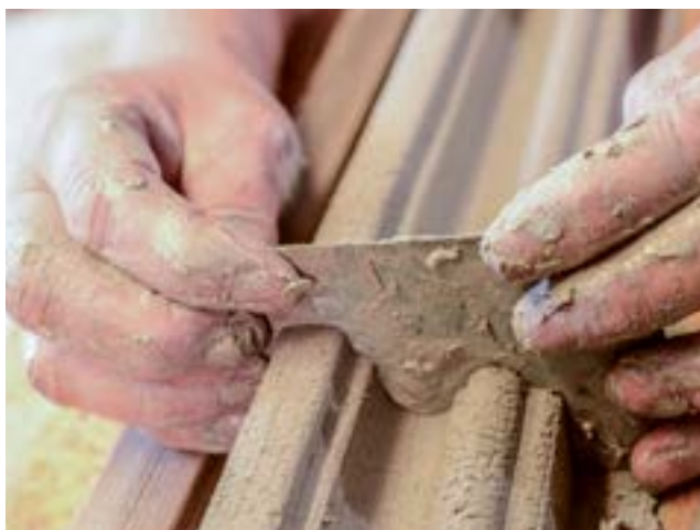
Tažení profilu římsy za pomoci kovové šablony.
