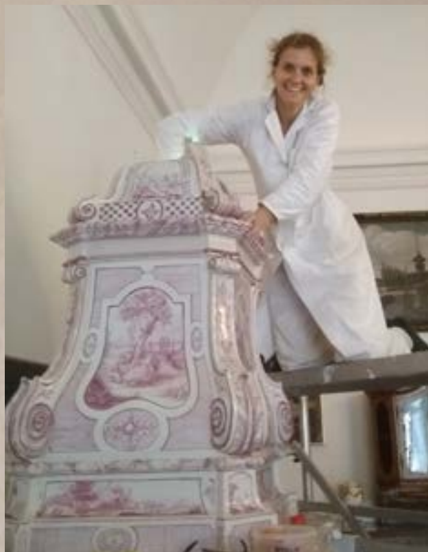
Radka Bukovjanová při ukotvování uvolněných kachlů (foto K. Fleková)
