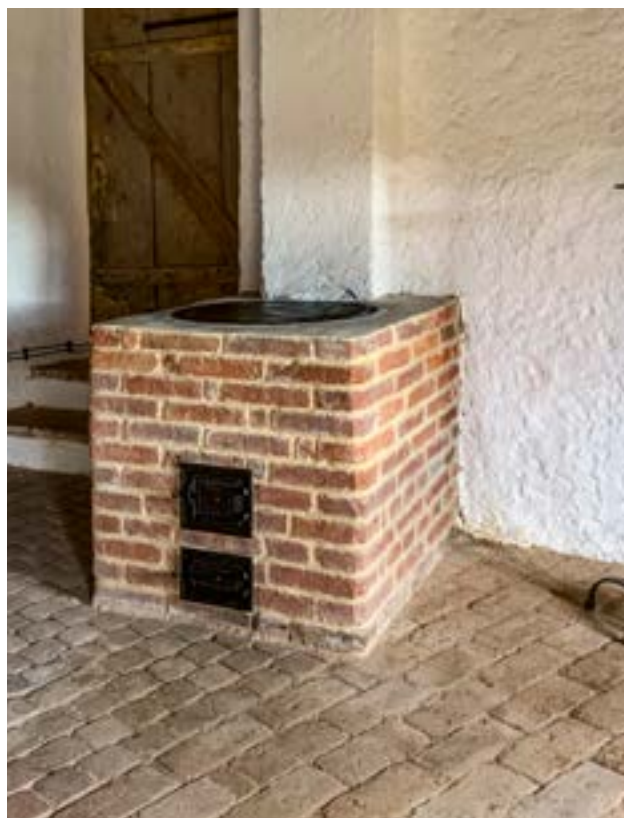
Cihlová pec po rekonstrukci byla dle požadavku zaklopena kovovou plotnou.
