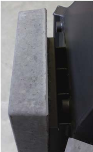
Detail systému zavěšení.
